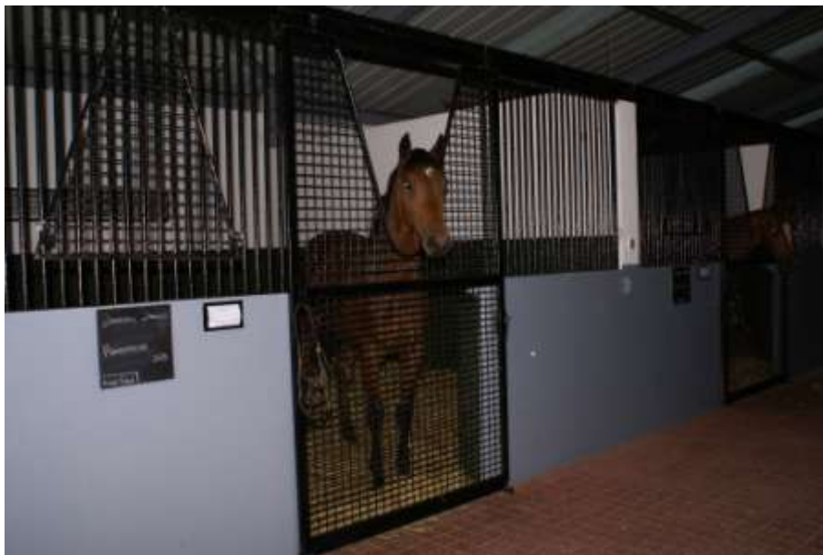
Fot. 10.3 Boks o ścianach i przegrodach murowanych z kratownicami. Drzwi z kraty ułatwiają cyrkulację powietrza w boksie. Koń ma możliwość wyglądania na korytarz a kształt wycięcia w drzwiach uniemożliwia mu tkanie. Stadnina Coolmore (Irlandia). Fot. A. Wróblewska
