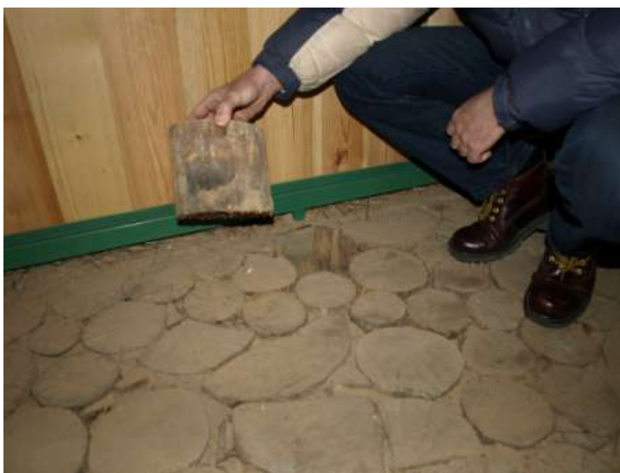
Fot. 10.7 Podłoga z kostki drewnianej w formie walców. Fot. J. Łojek
