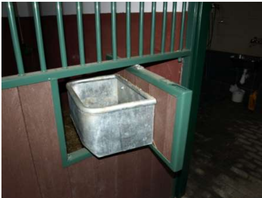
Fot. 10.4 Żłób obrotowy zamontowany w ścianie boksu prezentowanego na fot. 10.2. Fot. J. Łojek
