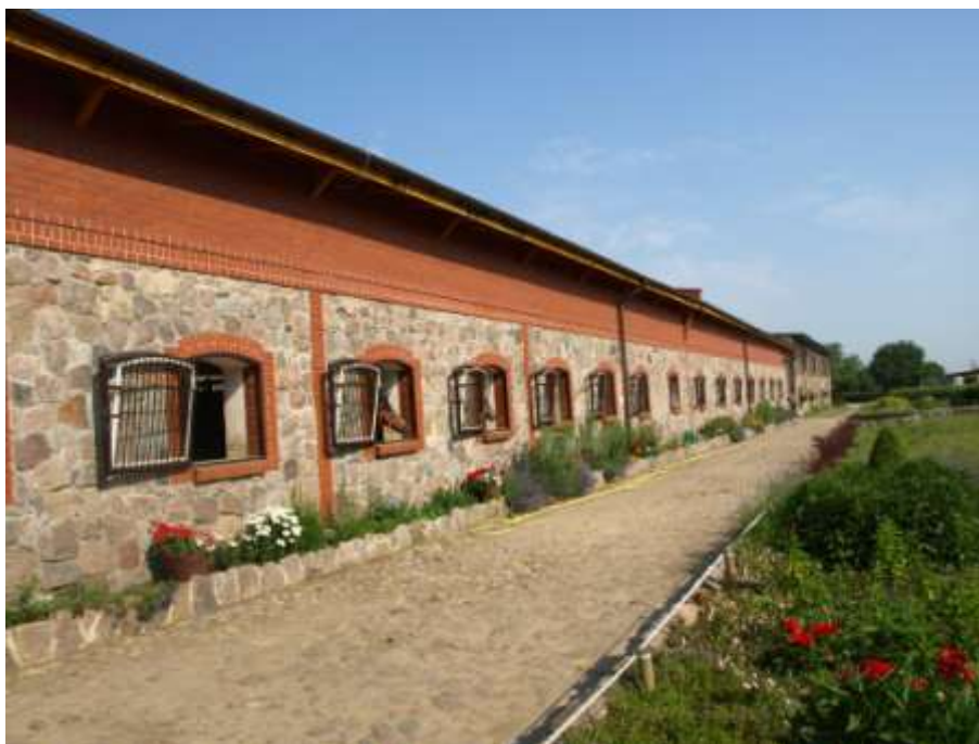
Fot. 10.5 Okna w boksach umożliwiające koniom wyglądanie na zewnątrz stajni. Stadnina koni w Żelichowie. Fot. J. Łojek
