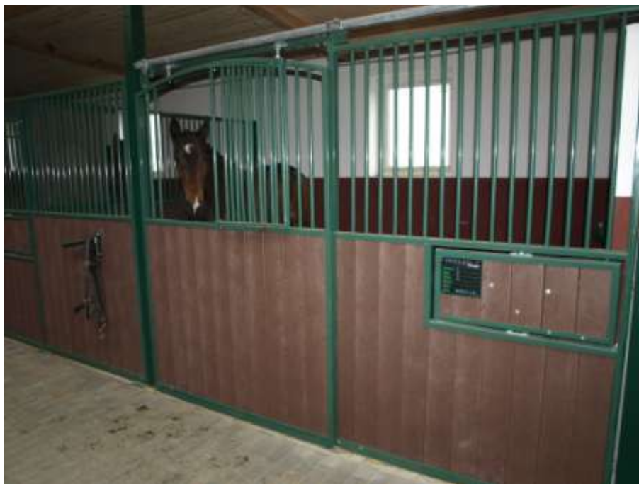
Fot. 10.2 Boks ze ścianami z masy plastycznej, kratownicami i przesuwanymi drzwiami. Fot. J. Łojek
